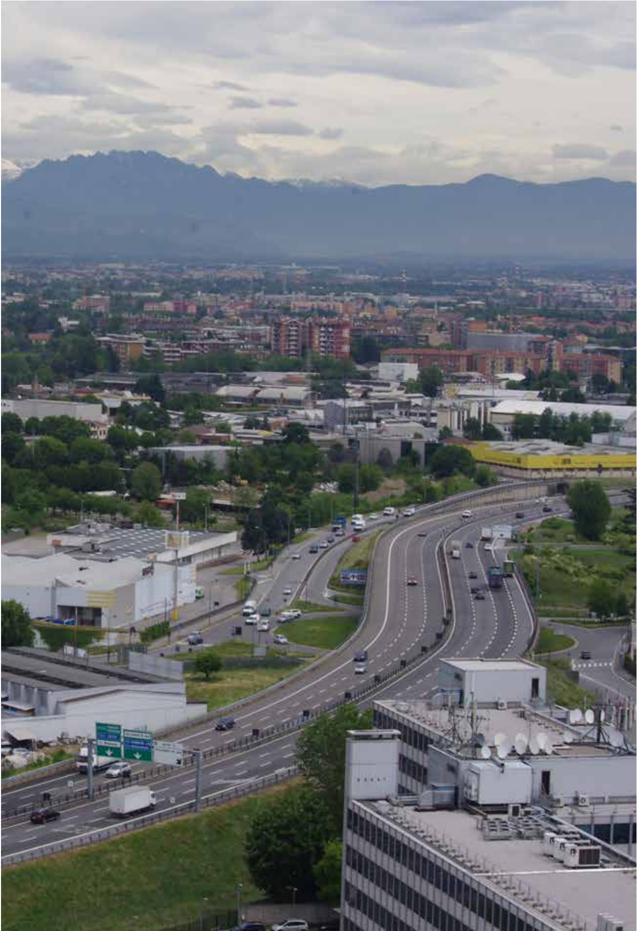
A51 Tangenziale Est - Cologno vista aerea
