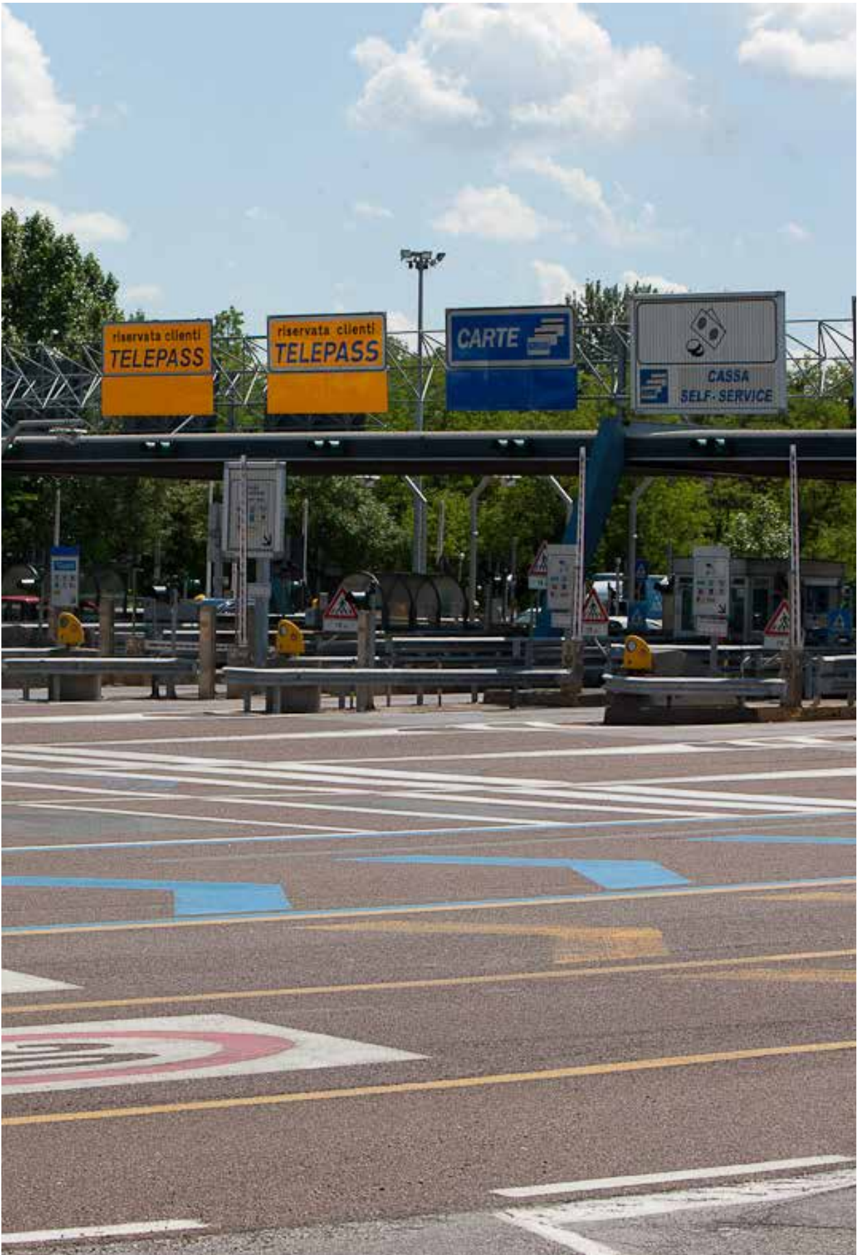
A52 Tangenziale Nord - Barriera Sesto San Giovanni
