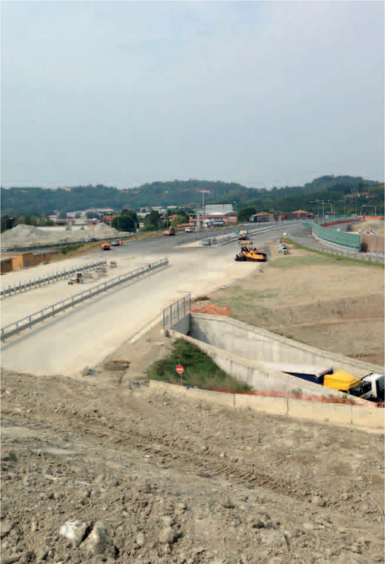
APL - Tangenziale Varese, rilevato in direzione svincolo di Gazzada A8
