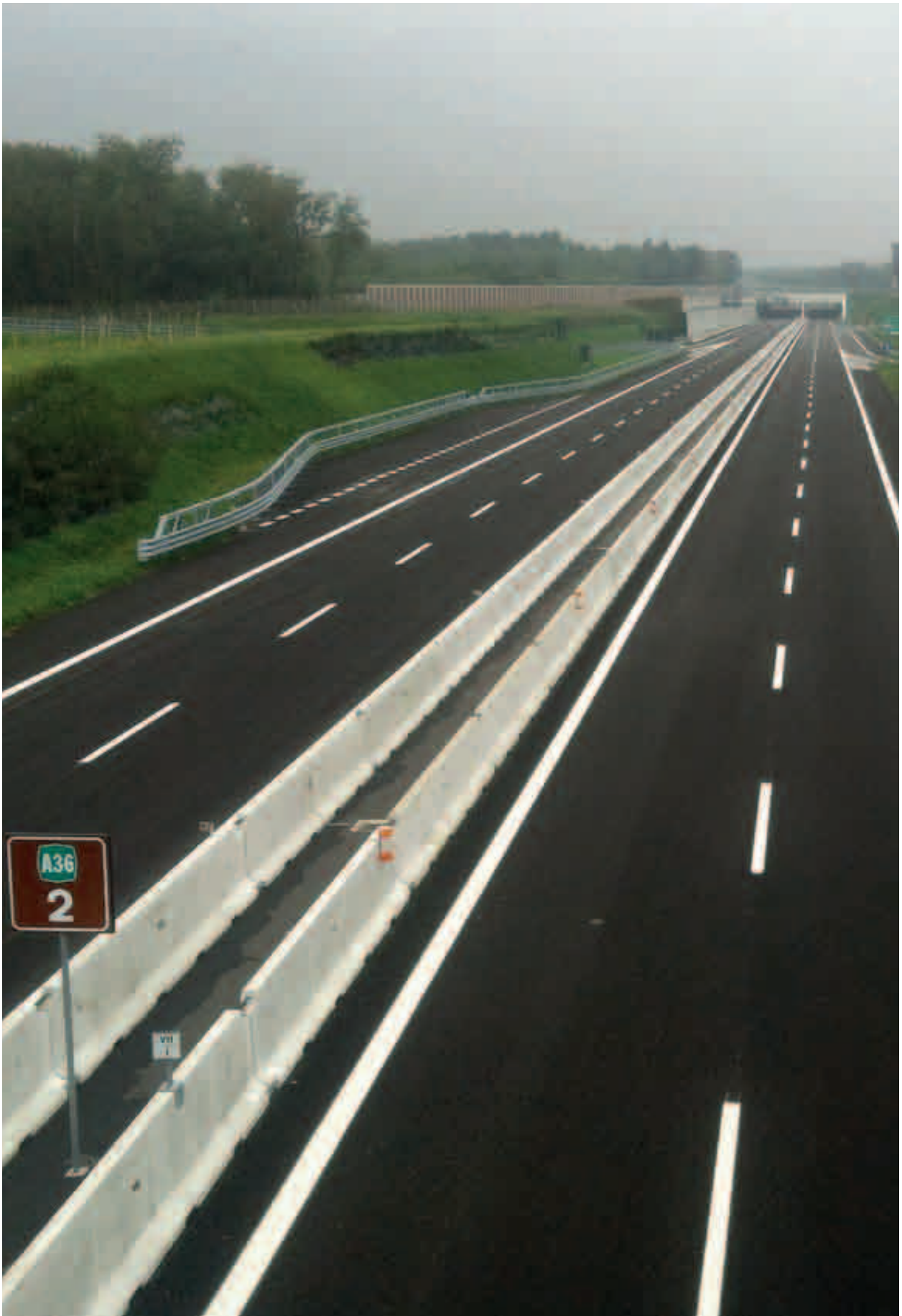
APL - Tratta A, trincea stradale in direzione Cassano Magnago
