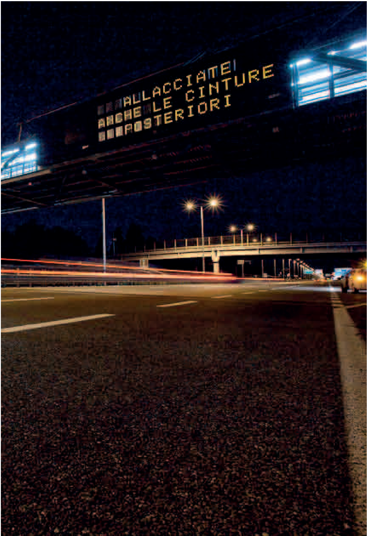
A7 Milano Serravalle - Pannello messaggio variabile
